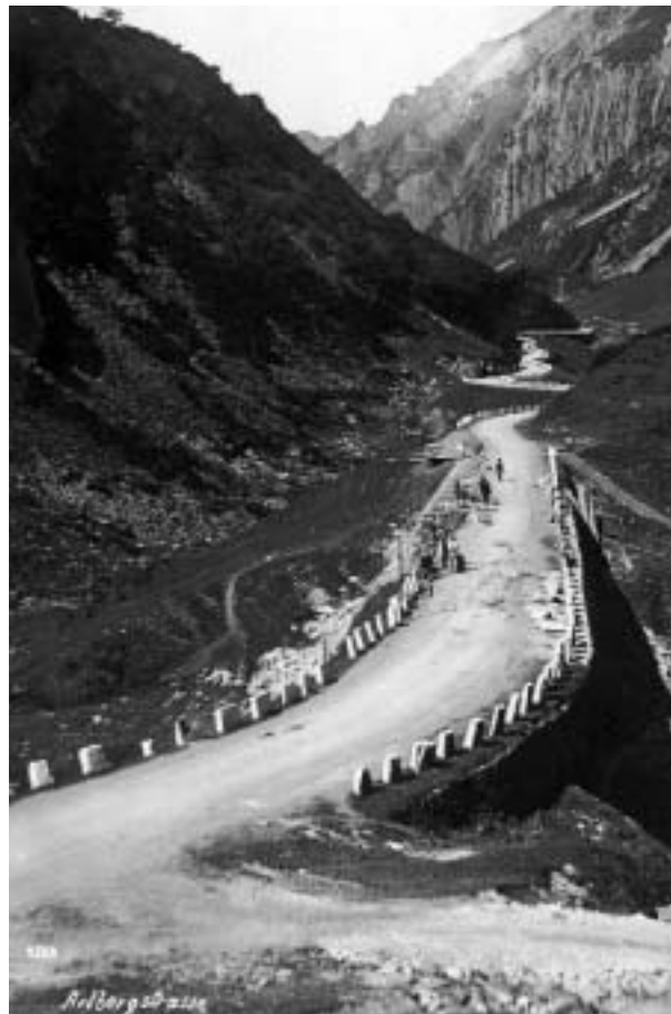
Wehrsteine (Randbegrenzung) an der Arlbergstraße
